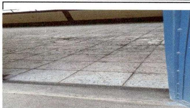
Foto 2: Sustitución de torta de cemento por piso de granito.
